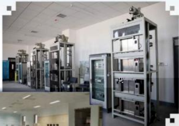
智能电梯安装调试 维护训练场所
